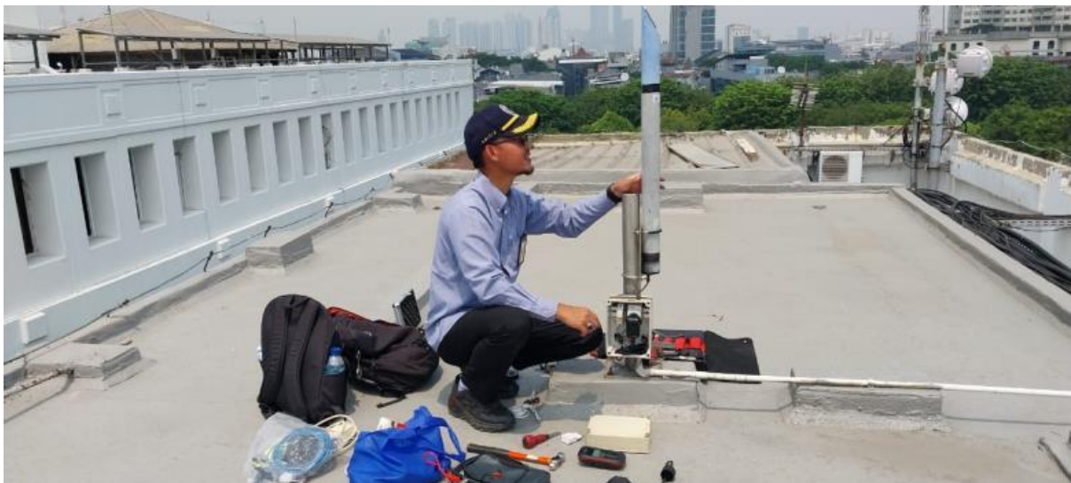
Gambar 58. Pemasangan MIRA Detektor I-RDMS Kawasan Istana Negara Merdeka
