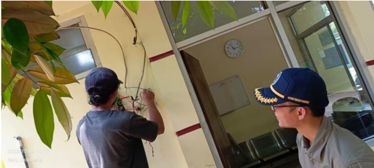
Gambar 56. Perbaikan Intalasi Listri PLN sumber catudaya Redudansi Detektor MIRA PUSPIPTEK 1
