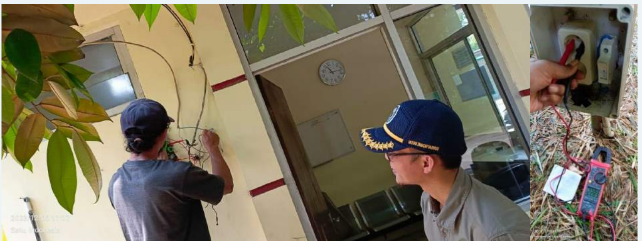
Gambar 94. Perbaikan Intalasi Listrik sumber catudaya Redudansi Detektor MIRA PUSPIPEK 1
