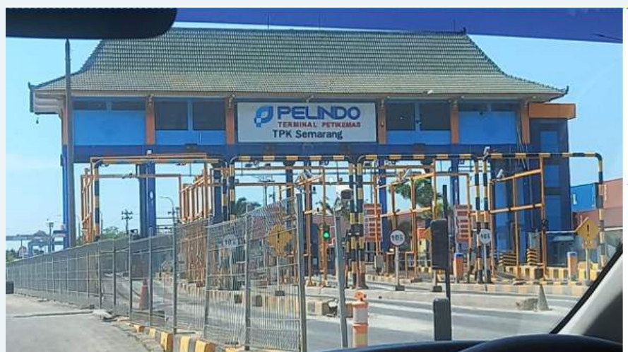
Gambar 105. Tinjauan ke lapangan di Terminal Peti Kemas Pelindo Tanjung Emas Semarang untuk pemanfaatan PMR hibah dari IAEA, posisi di portal gate depan untuk keluar masuk kontainer
