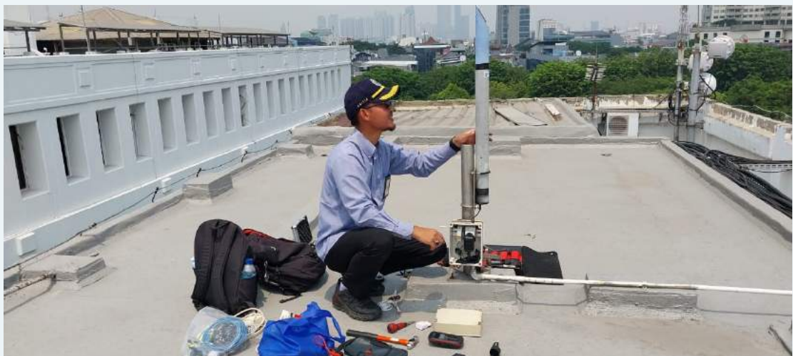
Gambar 96. Pemasangan MIRA Detektor I-RDMS Kawasan Istana Negara Merdeka
