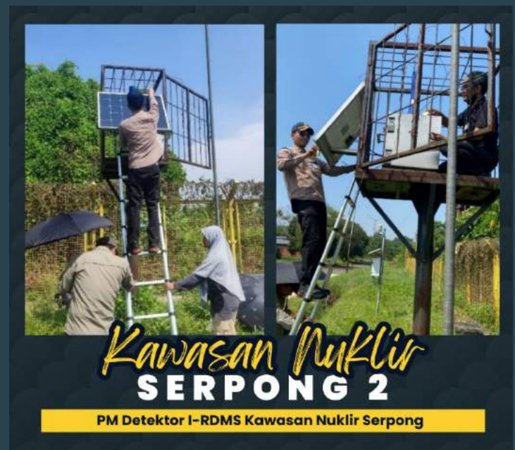
Gambar 85. PM Detektor I-RDMS Kawasan Nuklir Serpong 2
